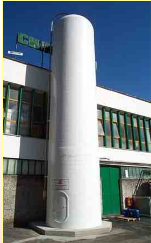
Silos en fibre de verre PVRF \varnothing 3 mètres h 12 mètres de 70m 3 installé auprès d'une Entreprise qui produit boissons gazeuses.
