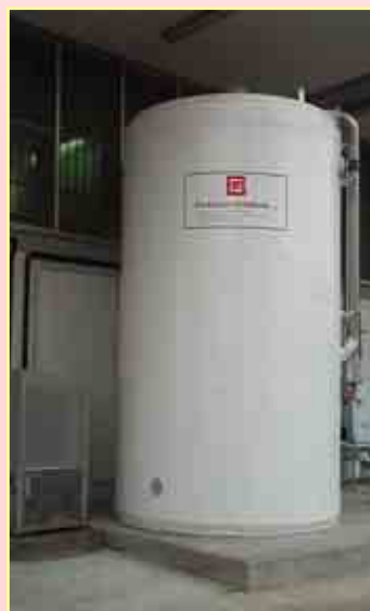
Silos in vetroresina PVRF \varnothing 3 metri h 12 metri da 70m 3 installato presso una azienda produttrice di bibite gassate.
