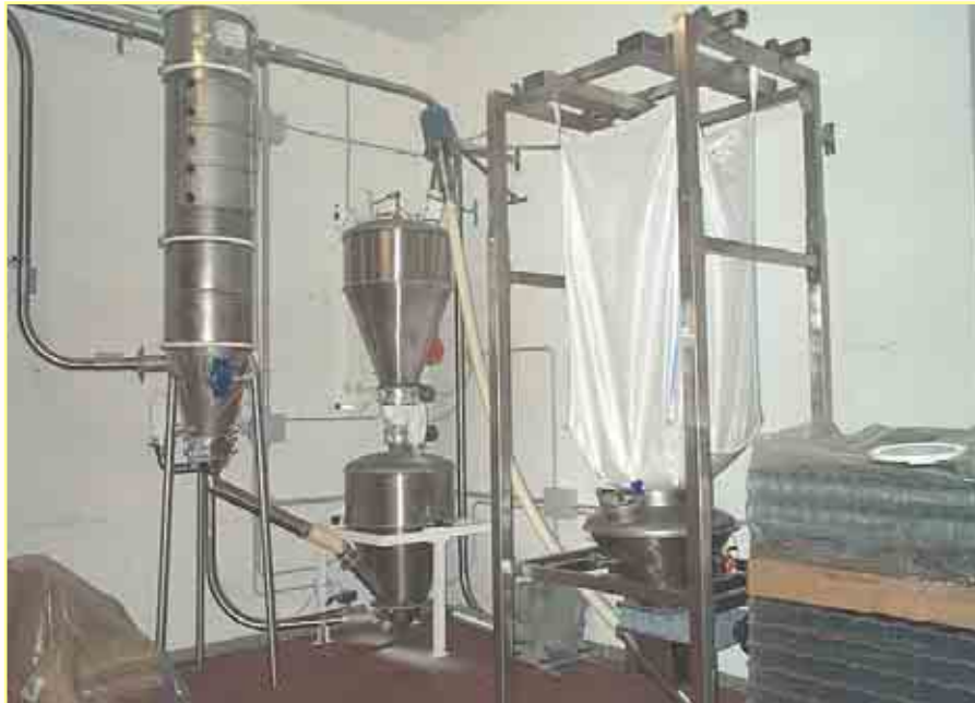
Stazione vuota big bag per l'automazione dello zucchero installata a Lovere (SO) in una azienda produttrice di marmellata.
