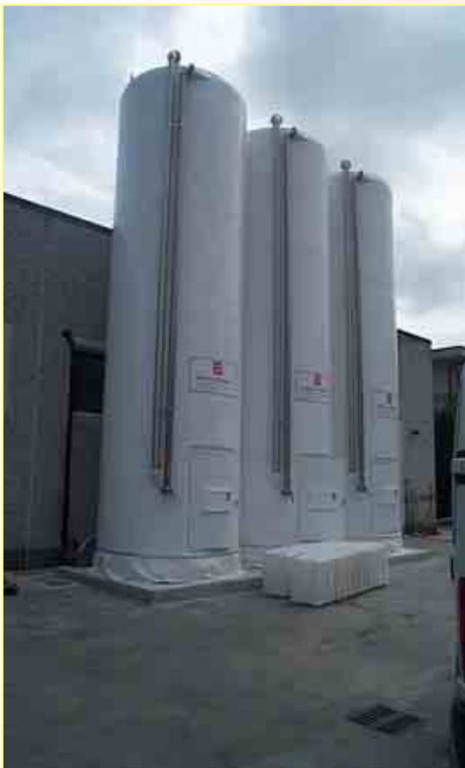
Almacenamiento en n.3 silos de 40 toneladas cadauno instalados sobre celdas de pesaje
