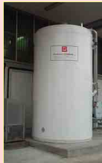
Silos en fibra de vidrio PVRF diam. 3mts. Altura 12mts. Cap.70m3. Instalado en una fabrica de bebidas
